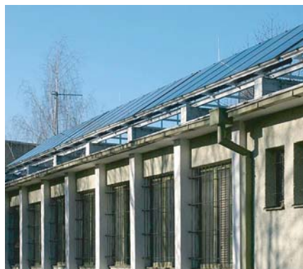
Obr.: Sídliisko Hliny – 132 kolektorov umiestnených na streche tepelnej výmenníkovej stanice
