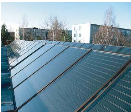
Obr.: Sídliisko Hliny – 132 kolektorov umiestnených na streche tepelnej výmenníkovej stanice
