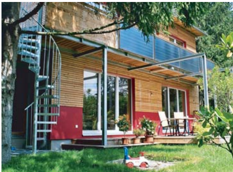
Južný pohľad s integrovaným kolektorom
