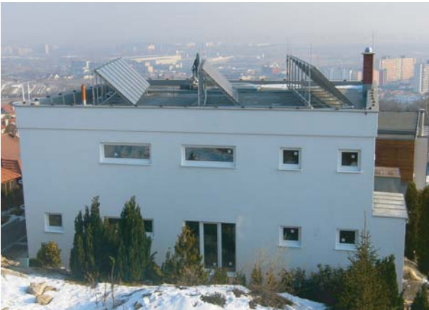
Obr: Využívanie slnečnej energie na ohrev bazénovej vody, pitnej vody a podporu vykurovania v Bratislave.
